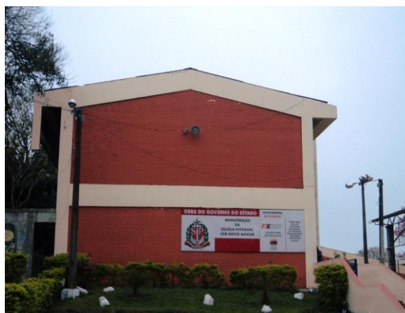
Foto 18 – Fachada da escola
