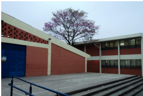
Foto 1 – Entrada para o pátio da Unidade Escolar
